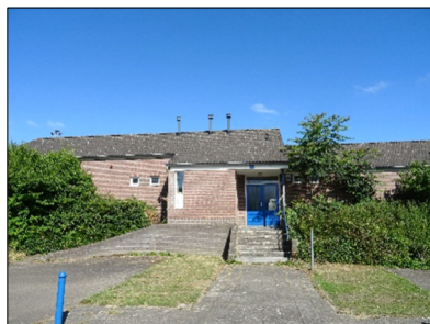
Figuur 2.3 Voorzijde clubgebouw, kijkrichting noordwest.
